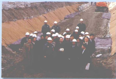
清溪川施工现场
