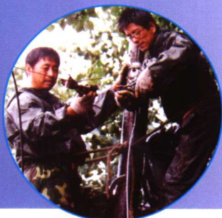
工程人员冒雨 抢修通信设备。
