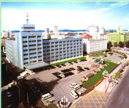
公司机关大楼
