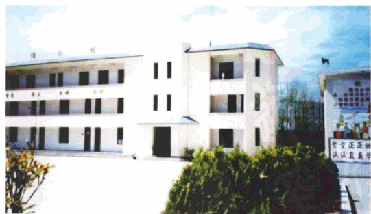
县特殊教育学校综合楼
