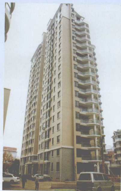
桂坡花园一期工程
