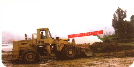
城镇廉租房开工建设
