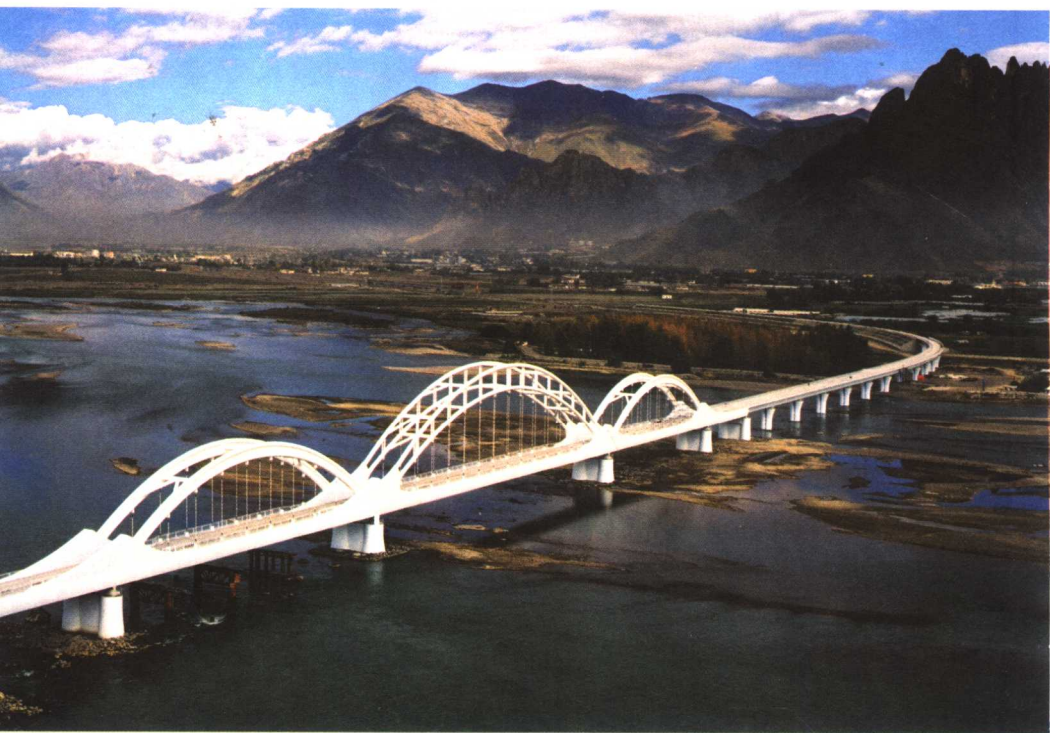
拉萨河铁路大桥
