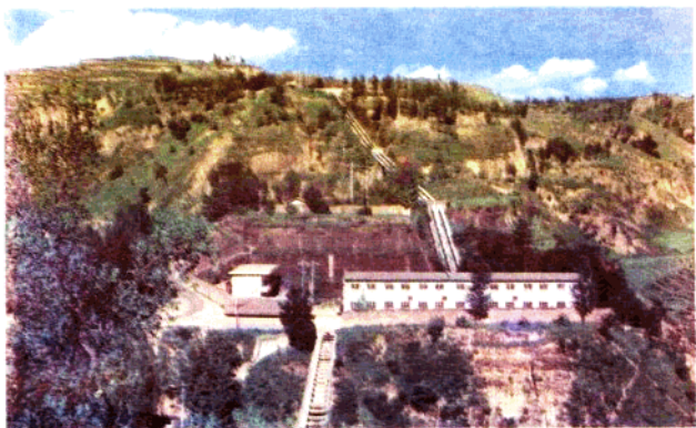
巴家嘴电力工程
