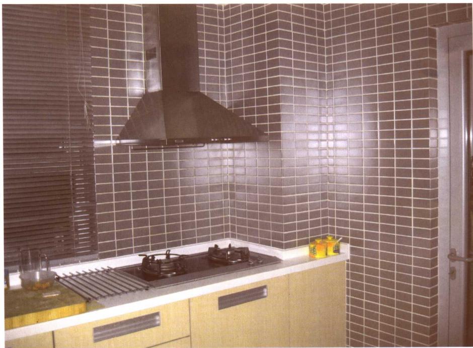
图 5-2 内墙釉面砖饰面
