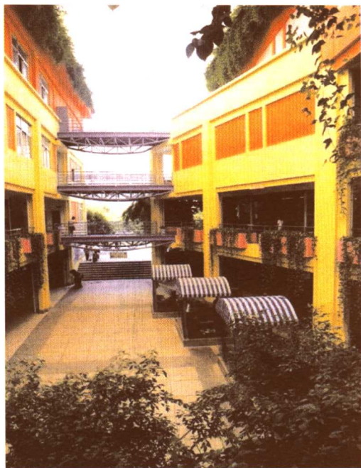
(a) 外墙涂料饰面
