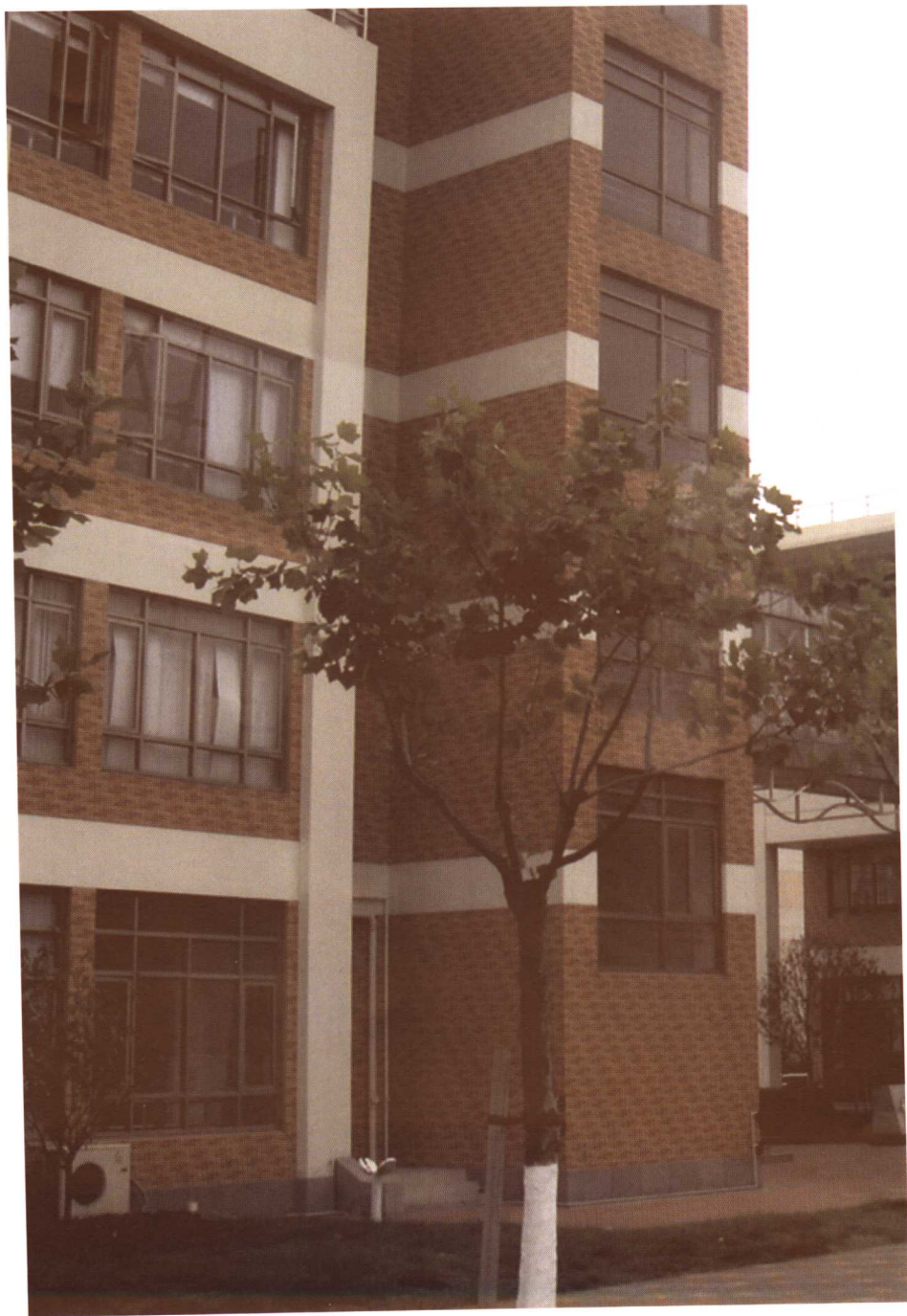
图 5-1 外墙面砖饰面 - 7 -
