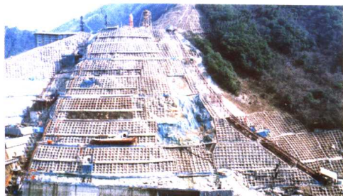
卷头插图1 温井水库大坝的混凝土框格(1996年)
