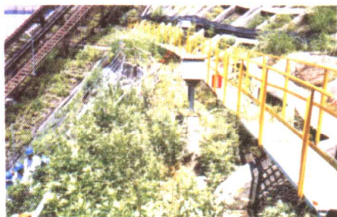
施工后1年半(护坡道)
