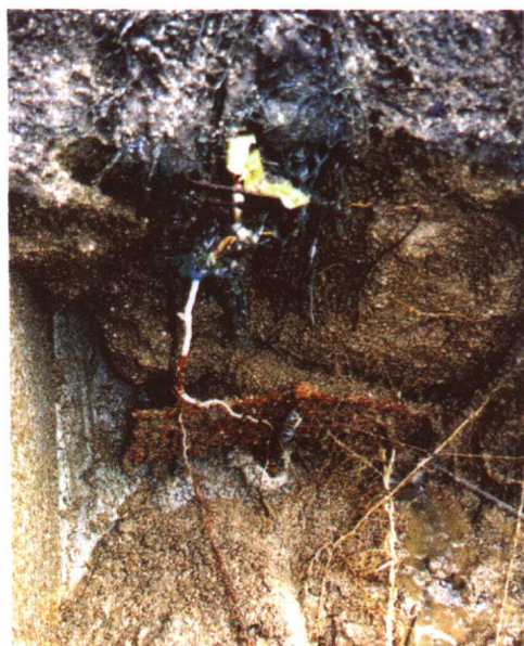
卷头插图11 植物的根系与锚杆的交织状态
