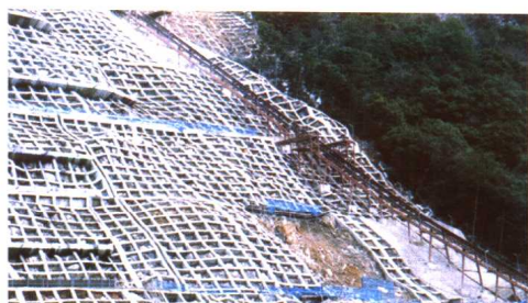
卷头插图1 温井水库大坝的混凝土框格(1996年)
