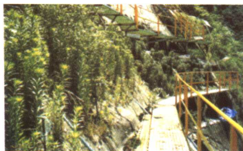
卷头插图9 温井水库坝址岩石坡面绿化试验(1997~1998年)
