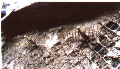
卷头插图10 锚杆的形状及其在岩石面上的设置状况
