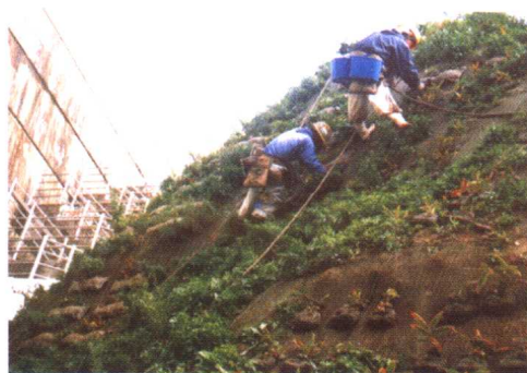
卷头插图3 温井水库坝址下游左岸岩石坡面绿化施工
