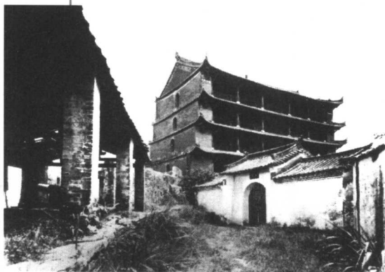
镇海楼旁女儿墙上的敌楼内静卧着几尊城防炮
