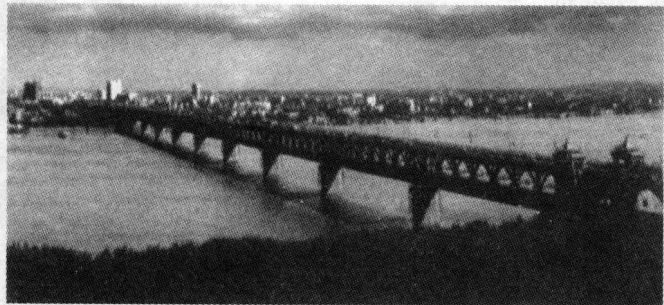
武汉长江大桥
