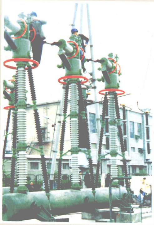
330千伏空气开关检修
