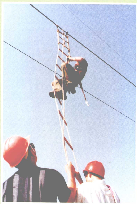
110千伏输电线路采用绝缘梯检修
