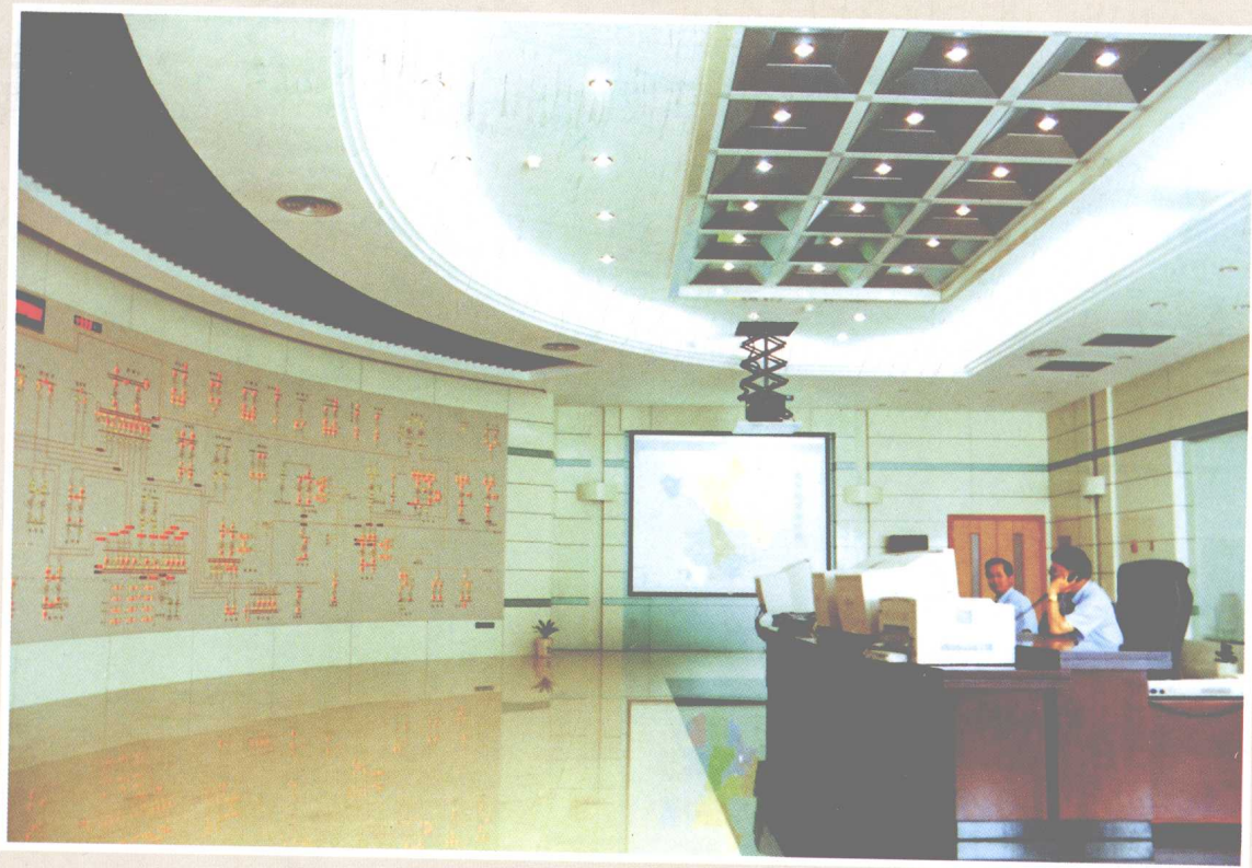
咸阳供电局电网调度中心
