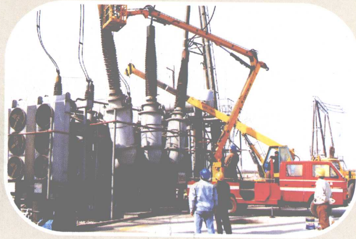
330千伏主变压器检修
