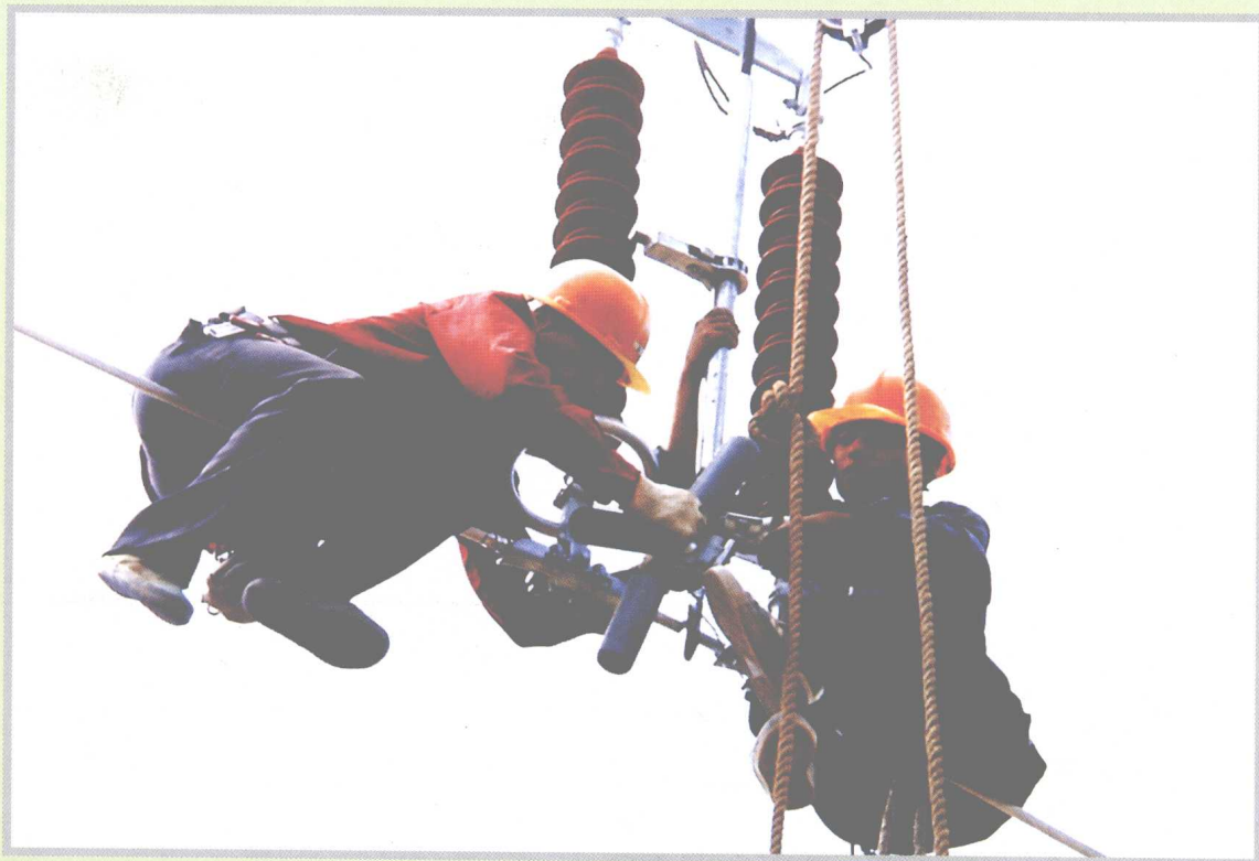
110千伏输电线路检修
