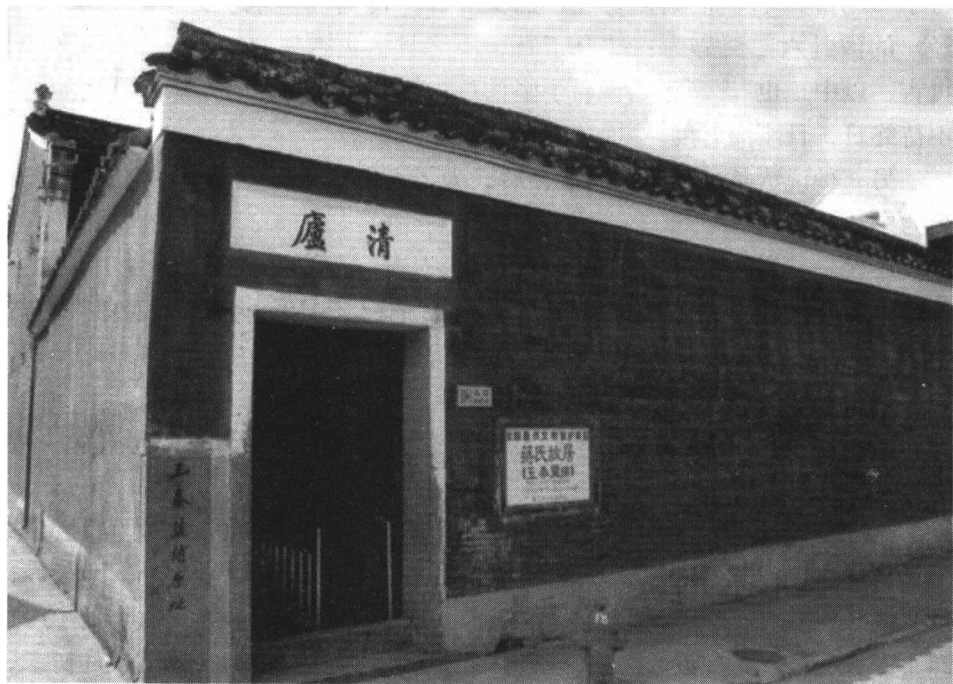
玉泰盐铺原址
