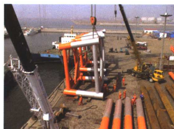
导管架陆地预制及装船
