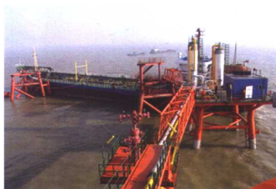
公司设计、施工、管理总承包的冀东LPN1试采平台
