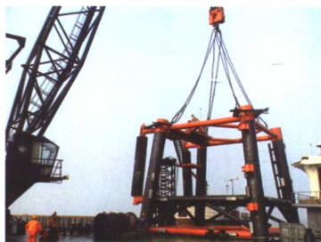
导管架海上安装
