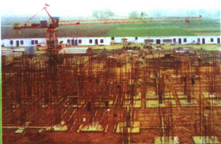
↑建设中的洛阳大学逸夫楼
