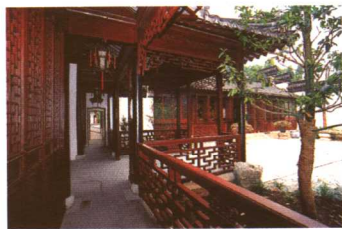
江苏苏州同里陈御史第外檐装修。外檐装修是作为室外装饰，并用以分隔室内、室外空间，如外门、外窗、栏杆及檐子等。
