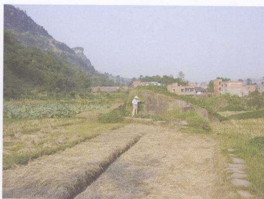
图版4-3 安乐寺滑坡后缘拉裂槽与陡壁
