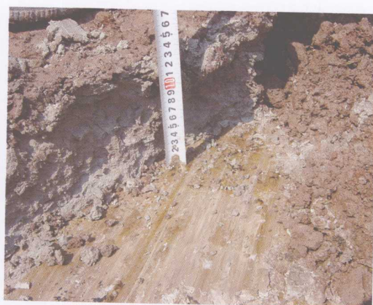
图版4-9 安乐寺滑坡第二层滑带(粘土夹角砾及下伏基岩上的滑动擦痕)
