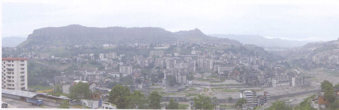
图版4-1 安乐寺古滑坡全景
