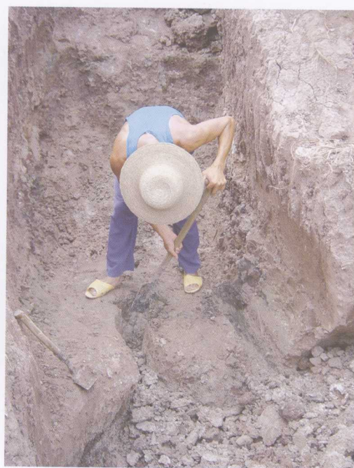
图版4-5 沿冲沟挖的探槽
