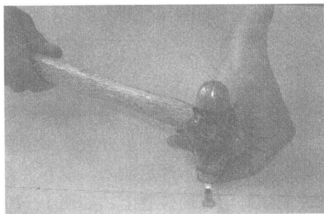
图 1—6 用锤子将钢筋轧片固定
