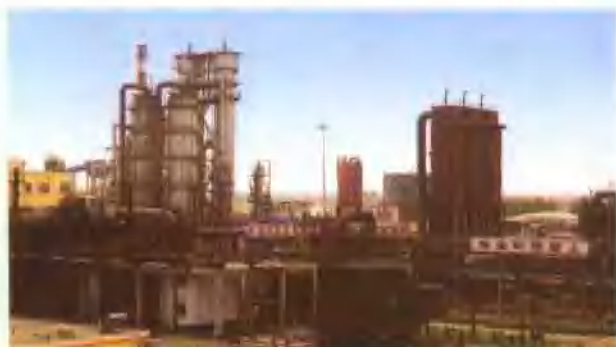
马鞍山钢铁股份有限公司、江苏沙钢集团、山东平矿集团合资建设的总投资6.2亿元的盛隆煤焦化项目
