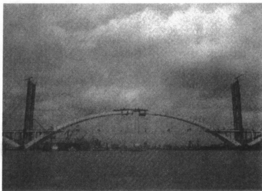
图 0-1 正在合拢中的上海卢浦大桥
