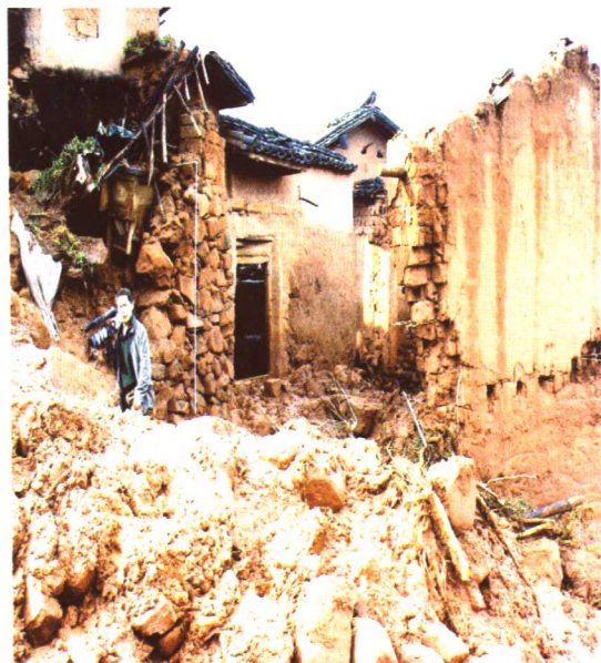
武定东坡乡以赤叻村发生重大山体滑坡灾害，造成14户农民房屋倒塌被毁，死亡15人
