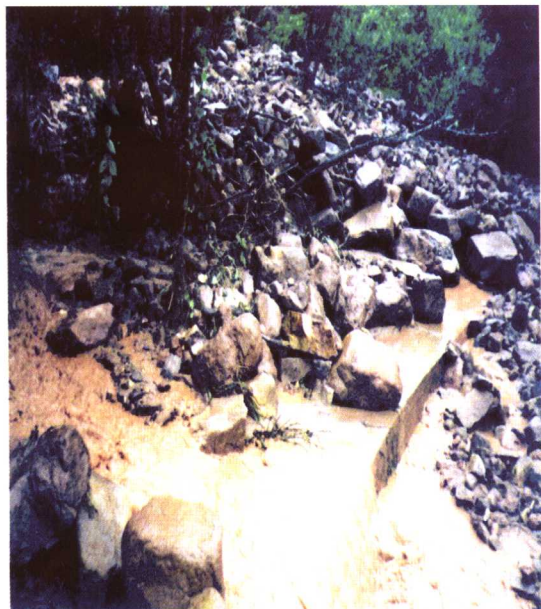
1999年8月1日，思江公路发生泥石流
