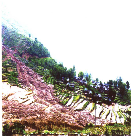
武定东坡乡以都莫村发生重大山体滑坡灾害
