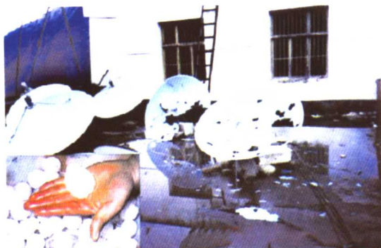
昭通昭阳区冰雹砸坏电视接收设施
