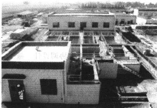
图 1-2 冯家山水厂沉淀池、砂滤池
