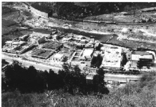
图 1-1 九公里水厂全景
