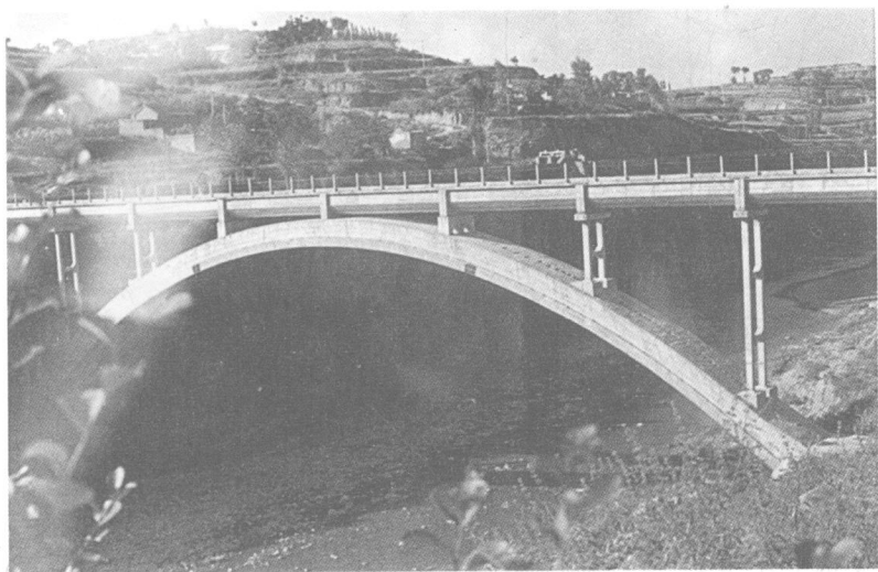
④ 梁庄渡槽
