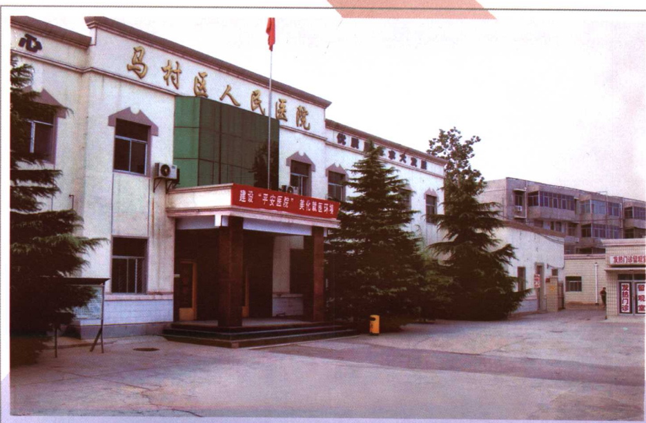
马村区人民医院门诊楼
