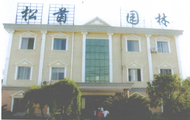
郑苗松创办的浙江松苗园林工程有限公司办公大楼
