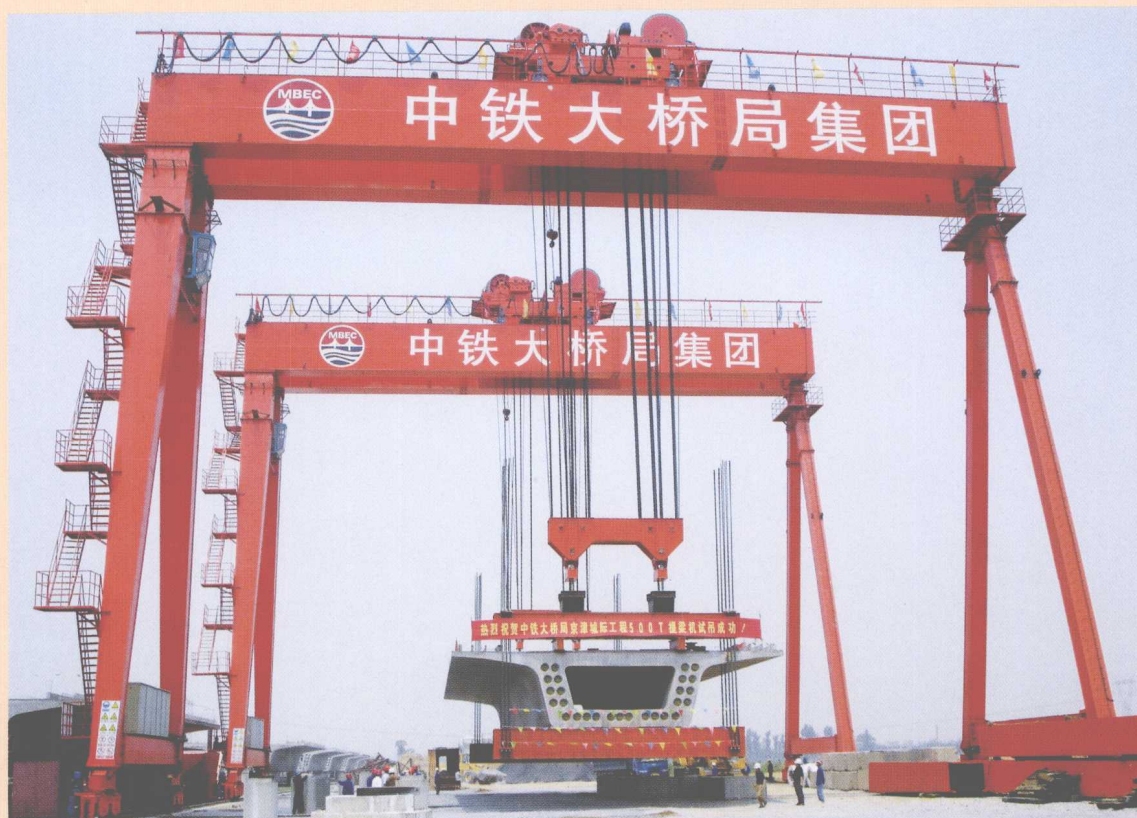
中铁大桥局京津城际项目 500 t 提梁机
