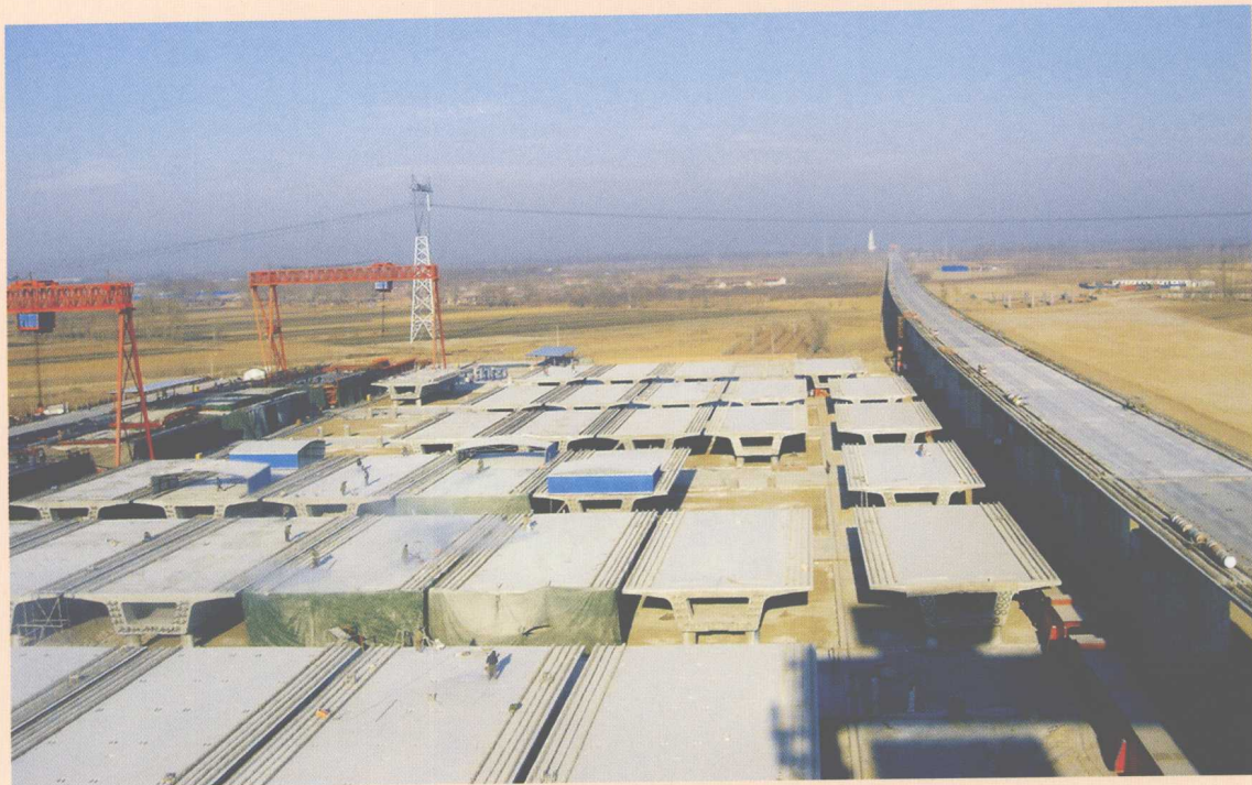
京津城际 3 号制梁场
