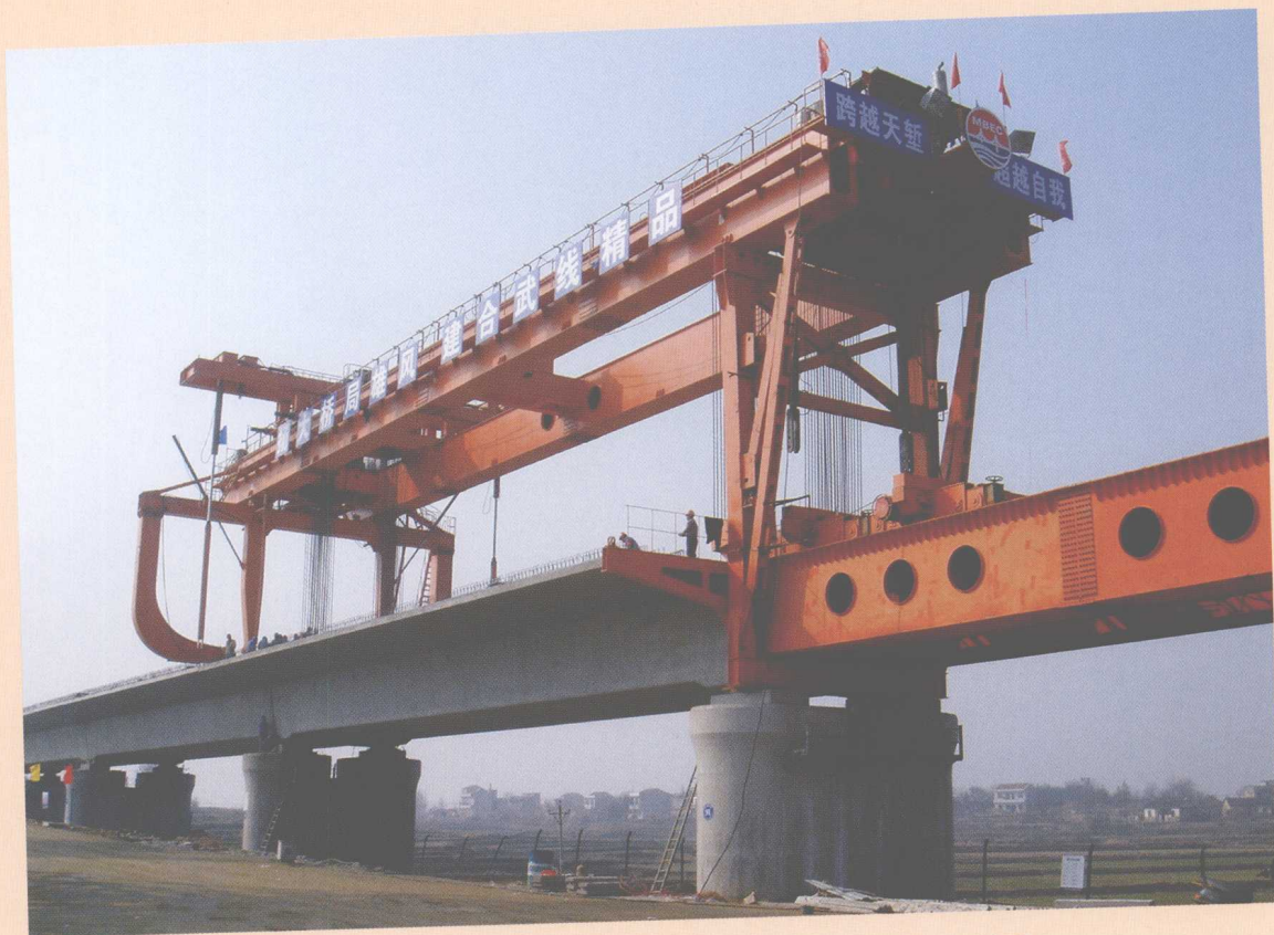
中铁大桥局合武线(湖北段) 900 t 架桥机架设 32 m 箱梁
