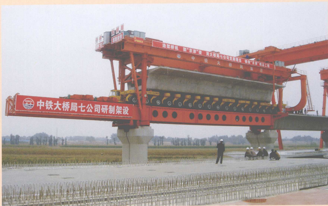
中铁大桥局京津城际项目 900 t 架桥机和运梁车架设 32 m 箱梁
