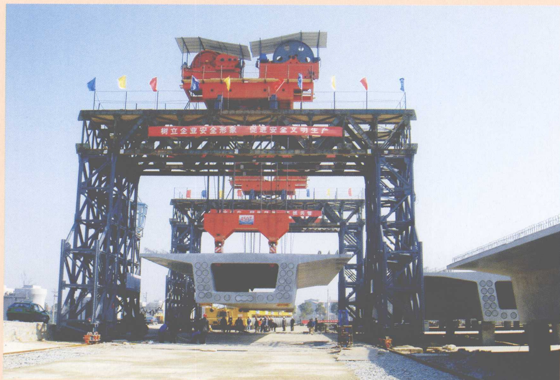
中铁大桥局合武线黄陂梁场 450 t 固定式提梁机
