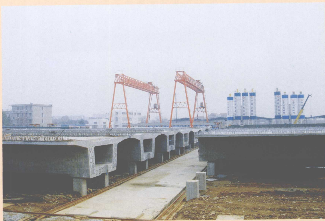
中铁大桥局合武线黄陂制梁场
