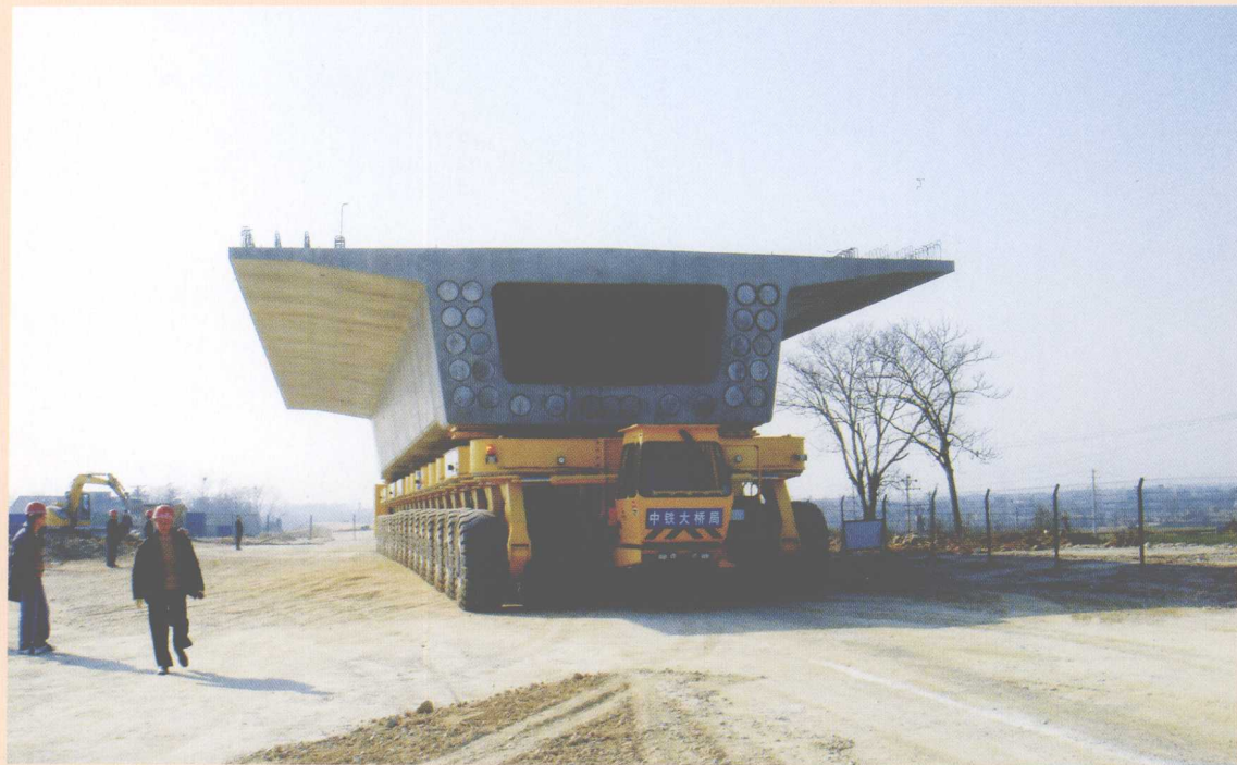
中铁大桥局合武线 (湖北段) 900 t 运梁车运梁
