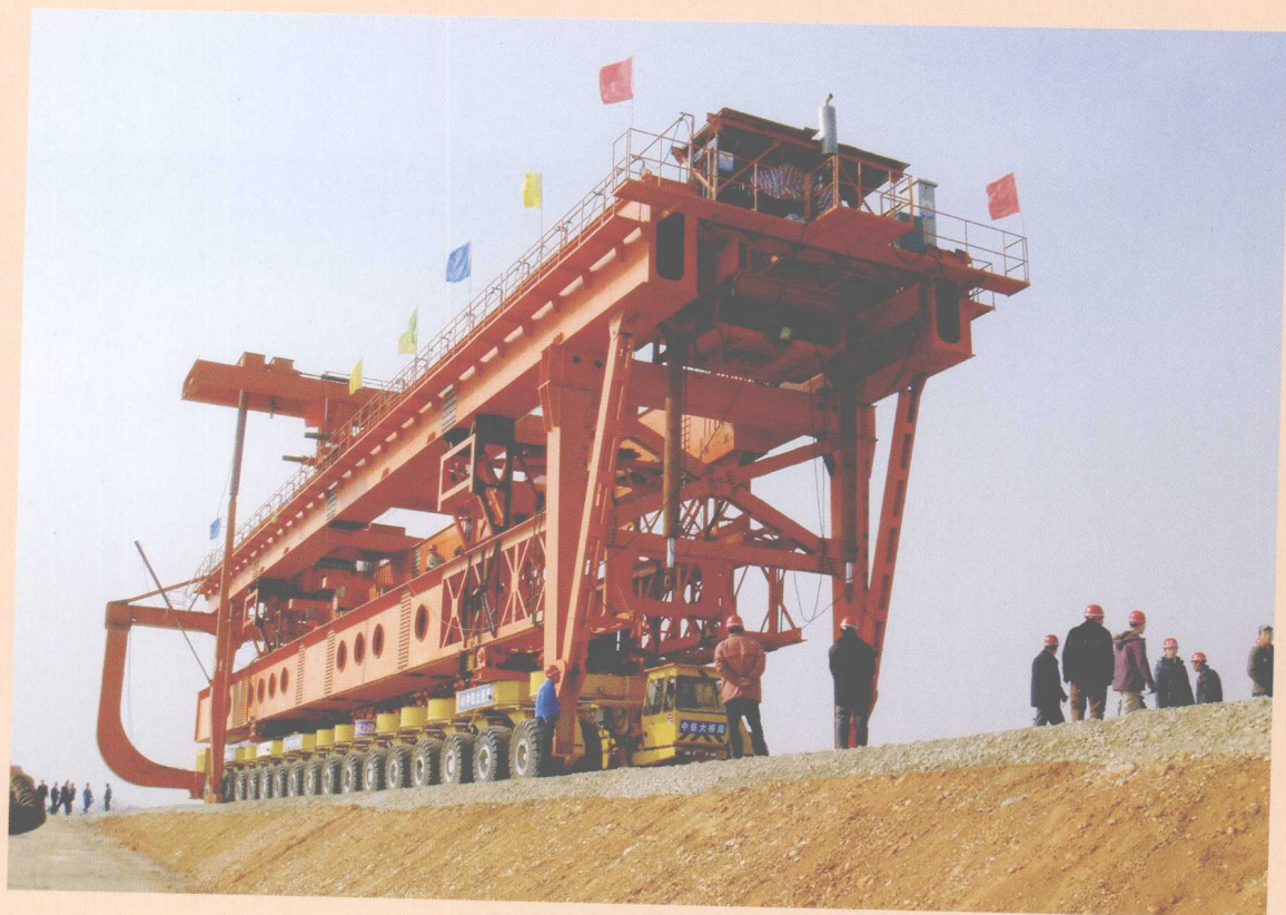
900 t 架桥机驮运转场
