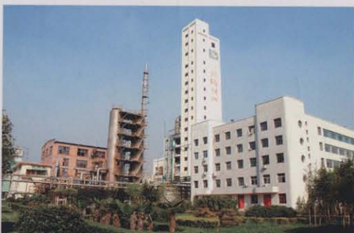
引进法国KT技术建设的18万吨硝铵生产装置
