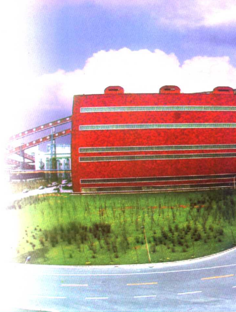
► 西部现代化精品板材基地炼钢主厂房
