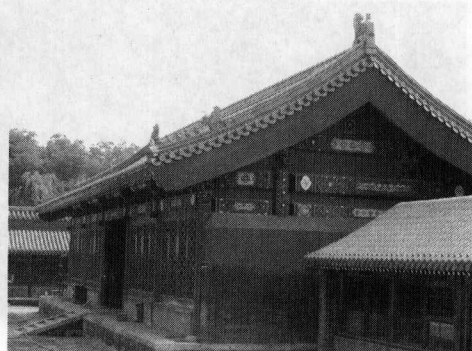
图2-2 悬山建筑，故宫武英殿西配殿
