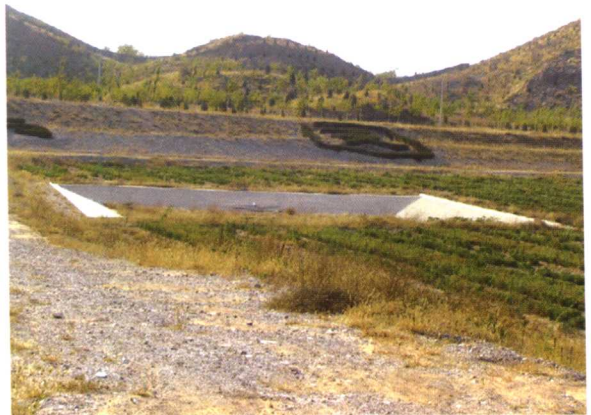
图4 整理后里炮片区修建的蓄水池
