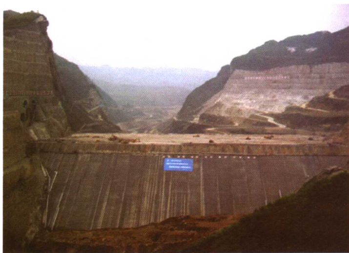
施工中的贵州洪家渡水电站锚索处理及帷幕灌浆工程
