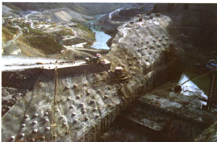
施工中的贵州引子渡水电站预留岩锚墙工程 (荣获国家科技进步奖)
