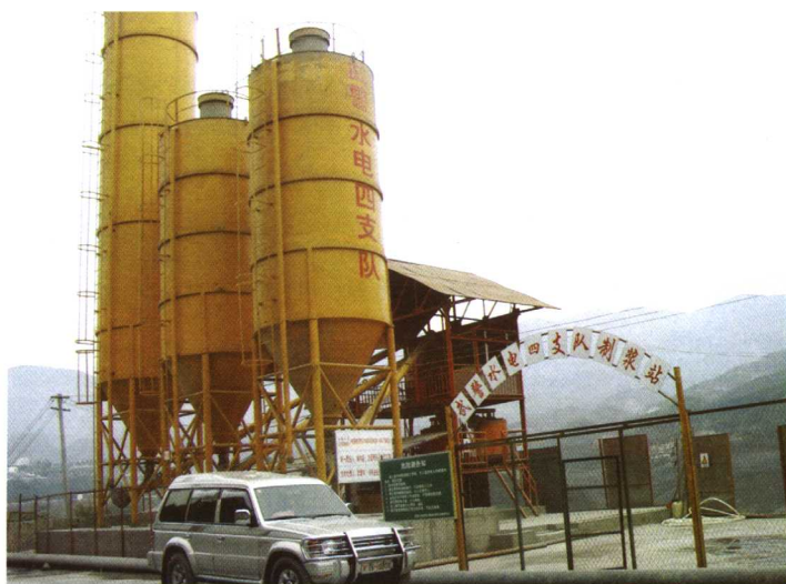
湖北清江水布垭帷幕灌浆工程高效节能环保集中制浆站
