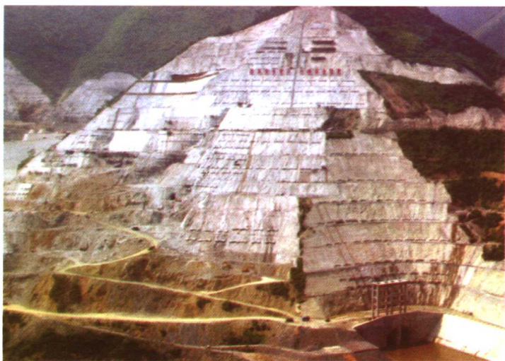
广西龙滩水电站右岸岸坡锚固处理工程
