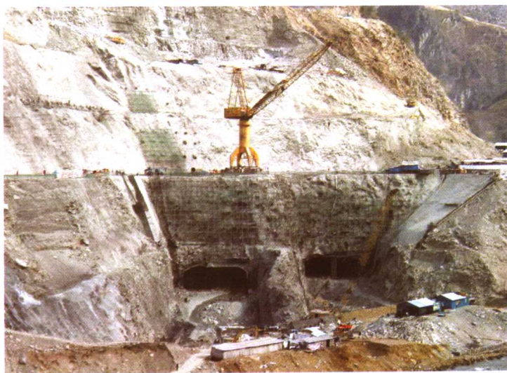
施工中的四川瀑布沟水电站岸坡锚固处理工程
