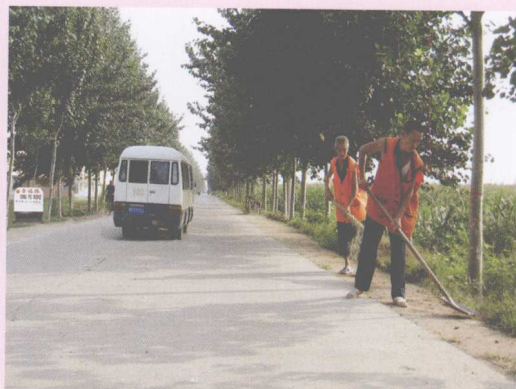
养护工人在修复路肩、清除杂草
