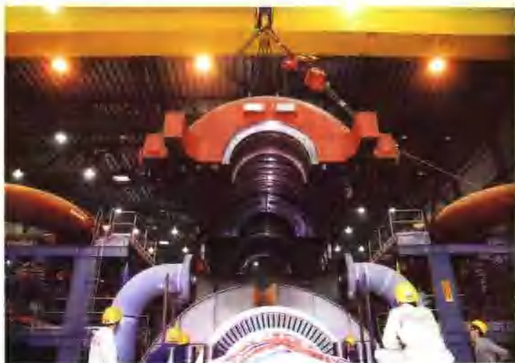
© 2001年9月16日, 1号汽轮机完成扣缸工作
