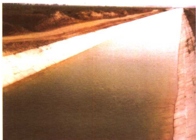
新建的防渗引水渠
