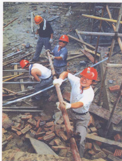
渡江桥改建工地上的建设者
