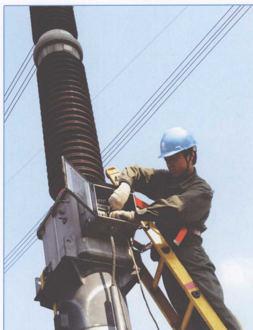
稳定切机装置接线
