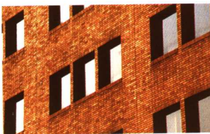
现代建筑平整光洁的清水砖墙。
