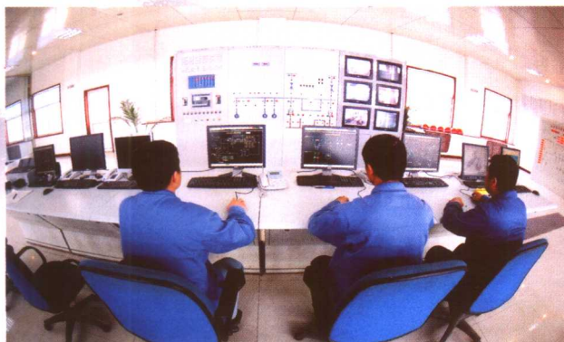
在省内较早利用新型干法旋窑水泥窑头余热进行发电,扩展了循环经济的发展空间
