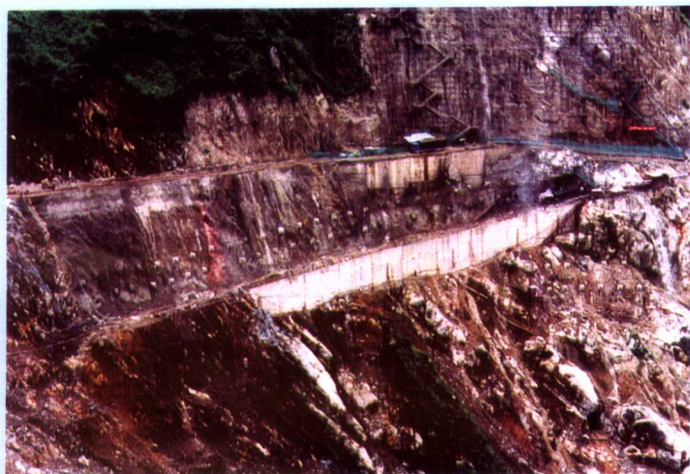
高缆边坡锚固全景
