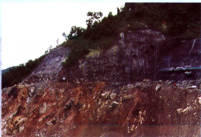
下游 A、B 区边坡锚固全景
