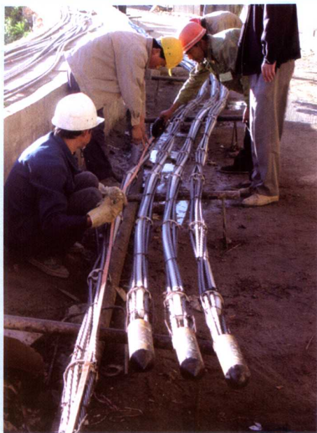
对监测锚索进行组装
