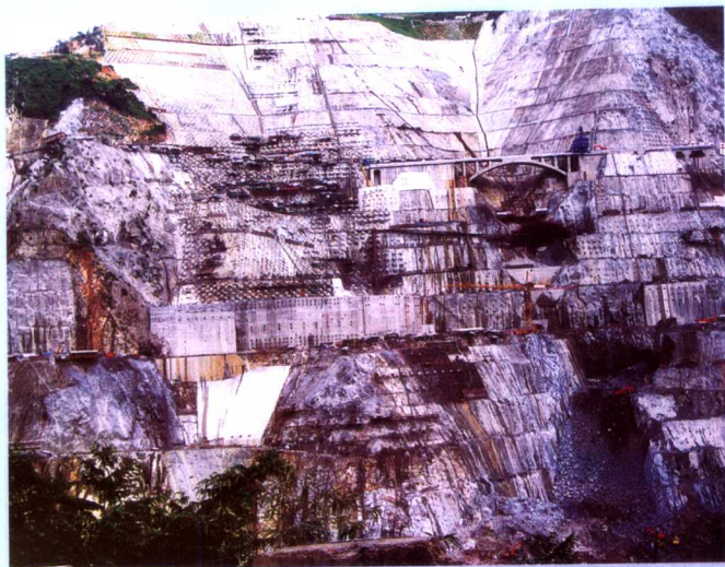
左岸2号山梁抢险锚索施工
