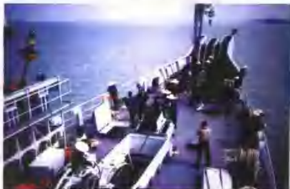
广东-海南海底电缆工程
