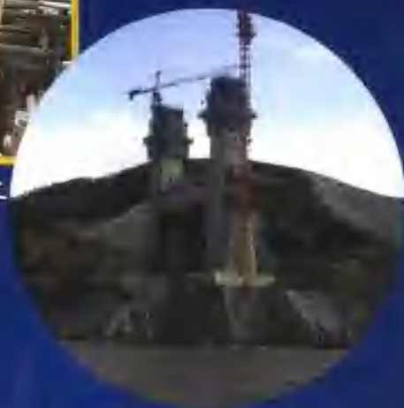
主塔爬模施工
