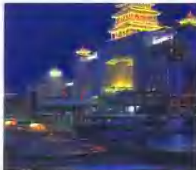
北京西客站通信信号工程
