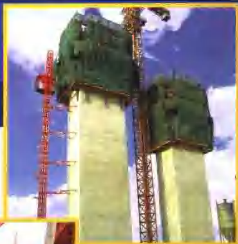
墩身模板施工
