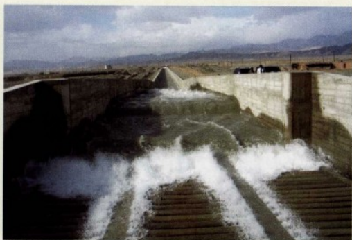
◎ 库河东岸总干渠大陡坡及消力池
