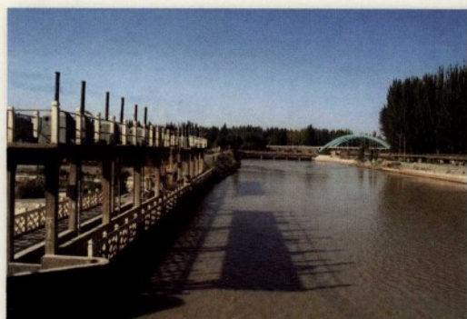
◎ 西大桥分水枢纽
