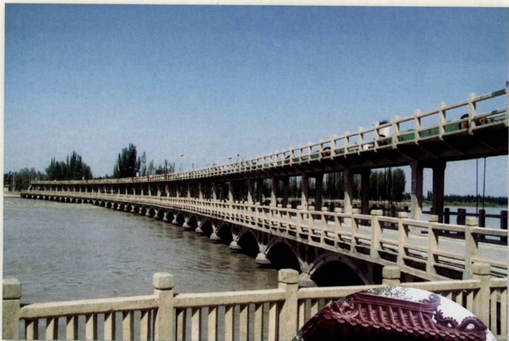
◎ 塔里木河拦河闸枢纽
