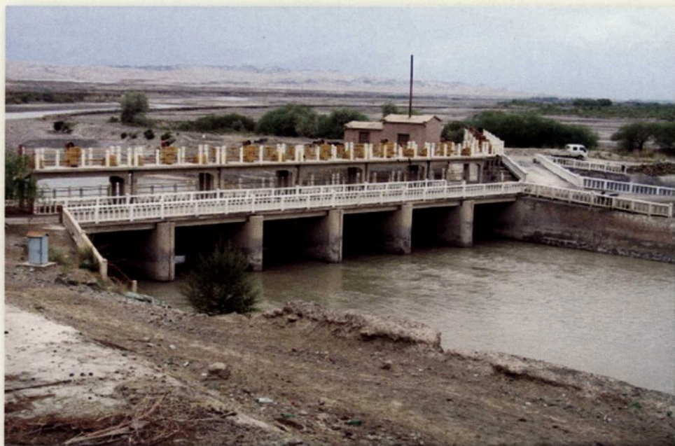
◎ 艾里西引水枢纽
