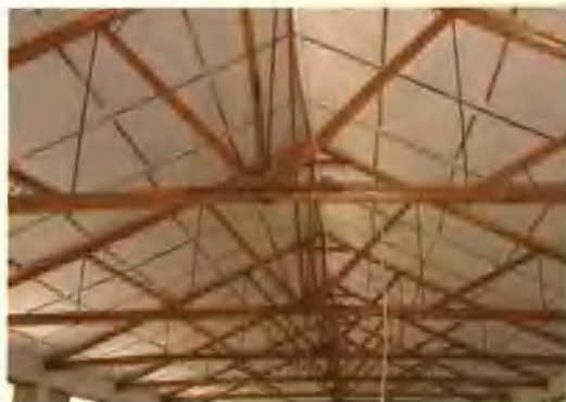
屋顶用泡沫塑料保温隔热
