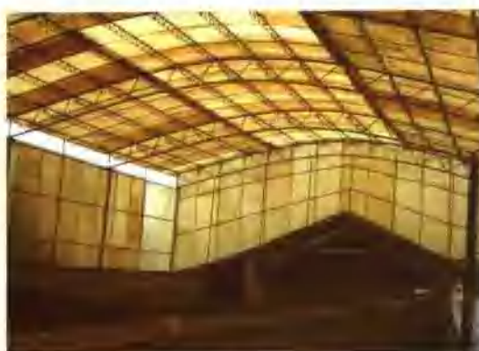
高槽式发酵槽
