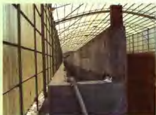
发酵槽边的污水沟
