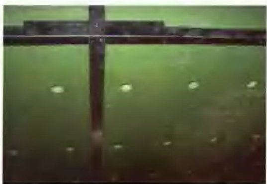
用泡沫塑料制成的上置箱式暖气输送系统
