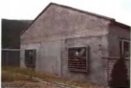
猪舍一侧装置轴流式风机
