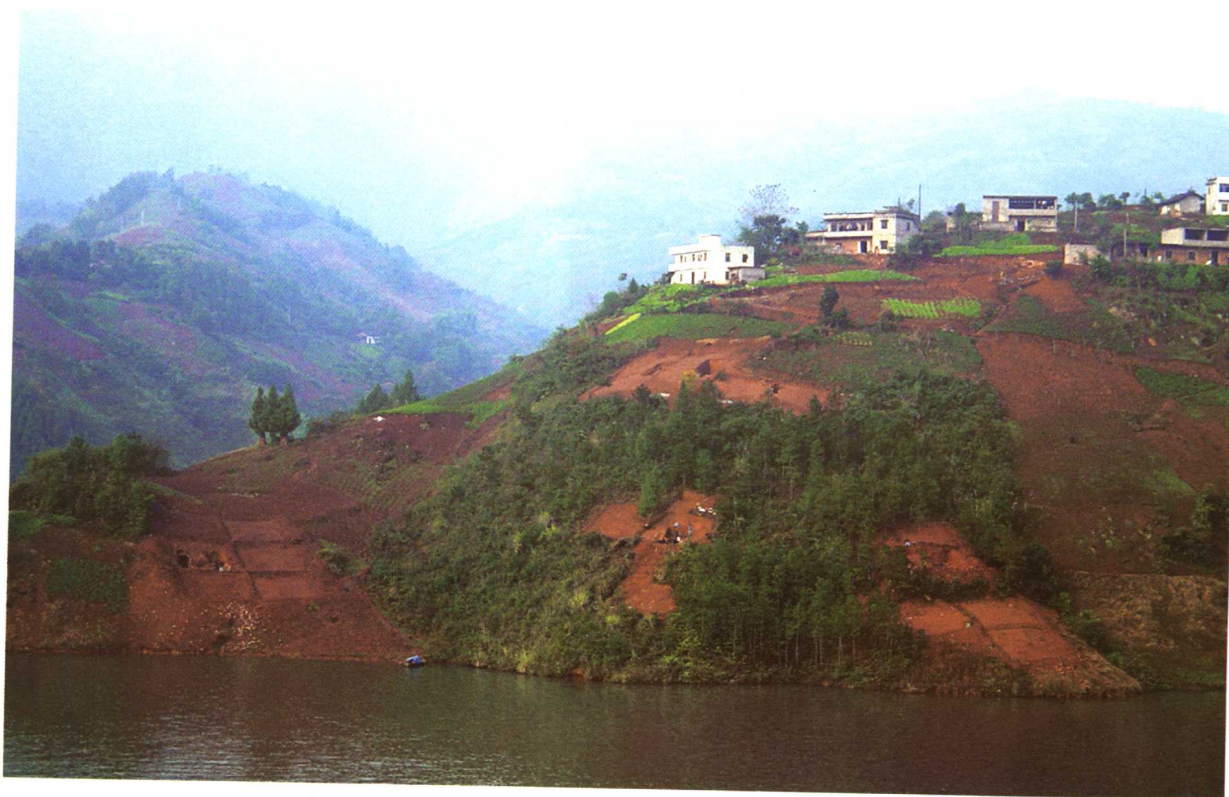
1. 发掘工地全景（由东向西）
