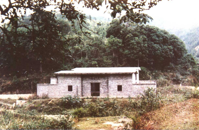
朱锡昂故居在沙河镇上垌村，按原样修复，这是两进厅厦带厢房的结构。
