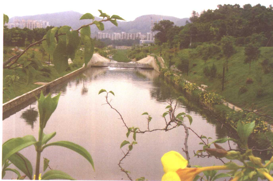
综合整治后的福田河
