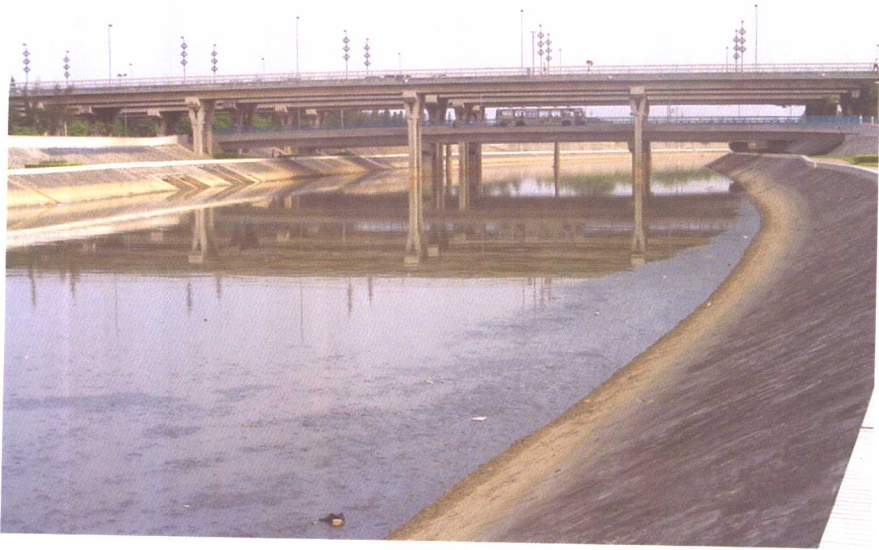
综合整治前的大沙河
