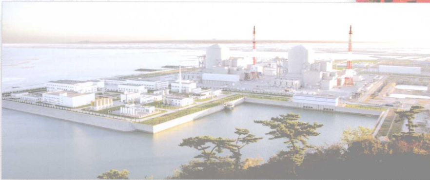
▲田湾核电站全景图
