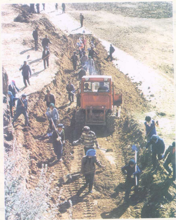
水洛镇李庄村修梯田现场
