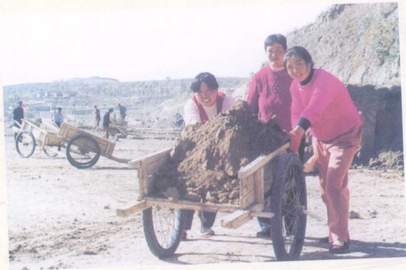
朱店镇高庙村梯田施工现场
