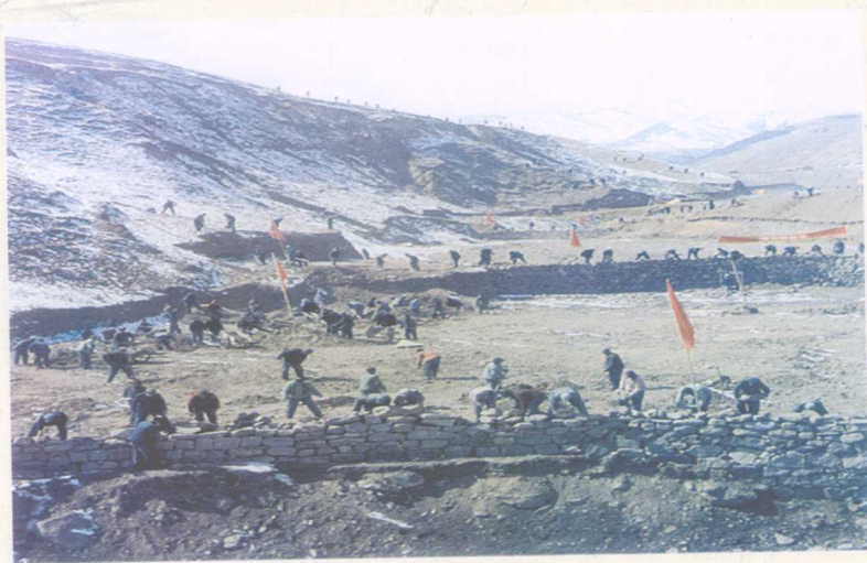
郑河乡上寨村梯田施工现场
