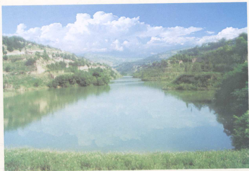
乱庄治沟骨干坝生态景观
