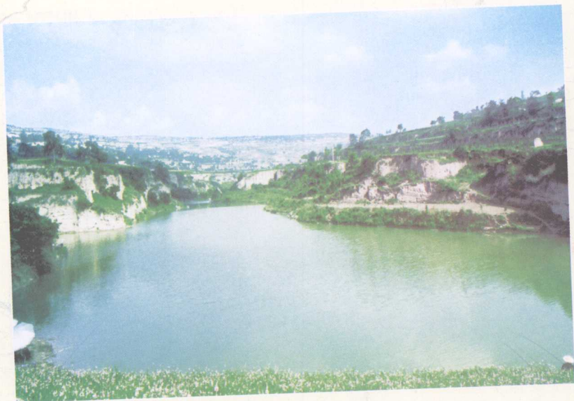
柳梁牛家沟淤地坝景观
