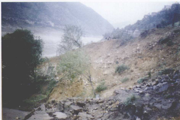
上、右图为1995年10月，巴东县持续降水，10月29日诱发塌方，使209国道受阻
