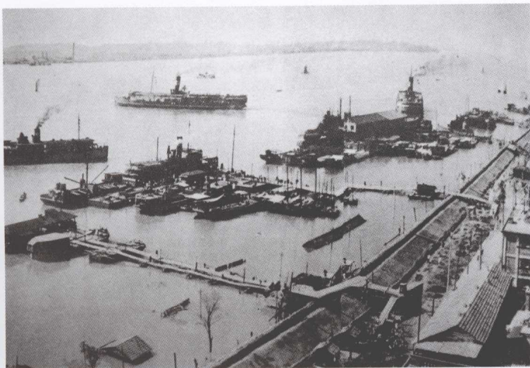
1954年，湖北遭受罕见洪水袭击，图为经过加固加高工程后的汉口沿江防水墙
