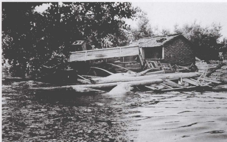
1998年嘉鱼县簪洲湾民堤溃口，牲畜爬到屋顶逃生
