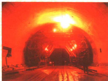
汪岔岭隧道施工场景
