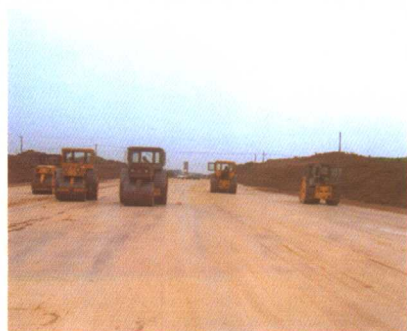
路基工程施工
