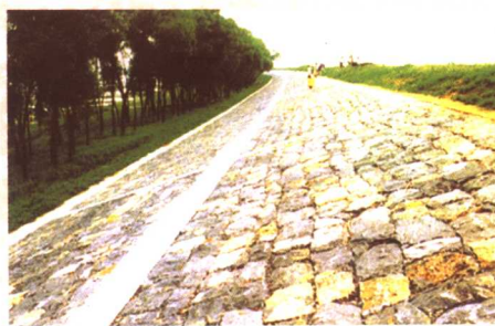
正南淮堤加固工程
