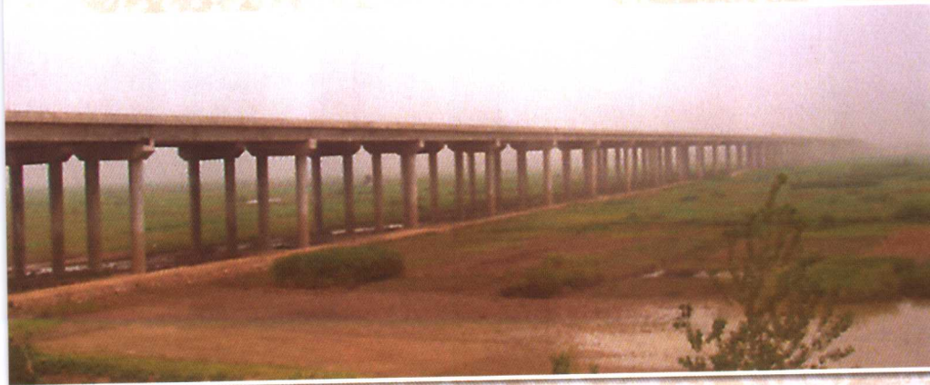
阜周高速淮河特大桥
