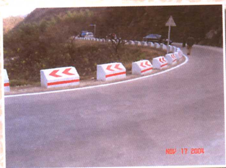
山区公路的安保工程
