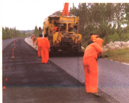
工人在维修公路
