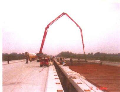
铺装大桥桥面
