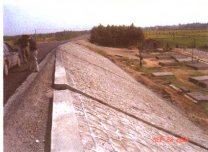
注重公路边坡建设
