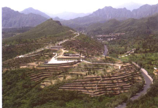
门头沟区担礼小流域综合治理
