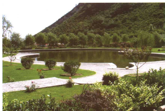
延庆县佛峪口生态清洁小流域综合治理
