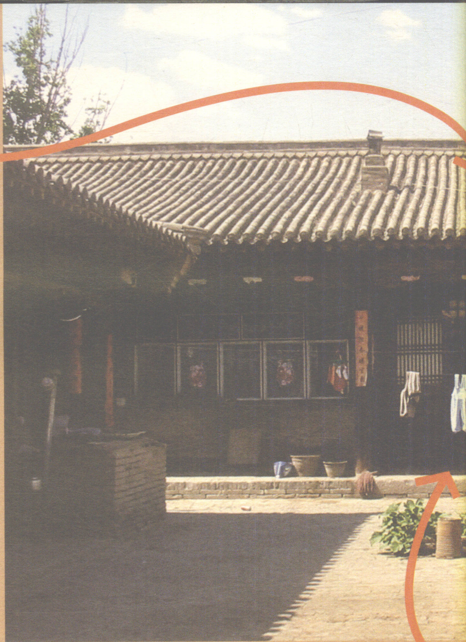
暖泉镇西古堡东楼房院第四进正房，原为二层，1981年维修时改建为一层
